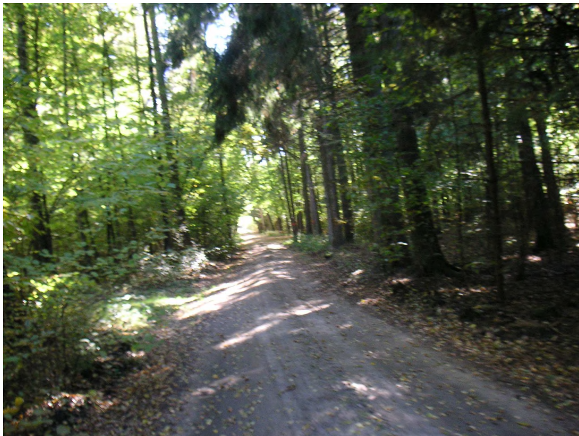
Zdj.1 Widok km 0+450 w kierunku zgodnym z kilometracją
